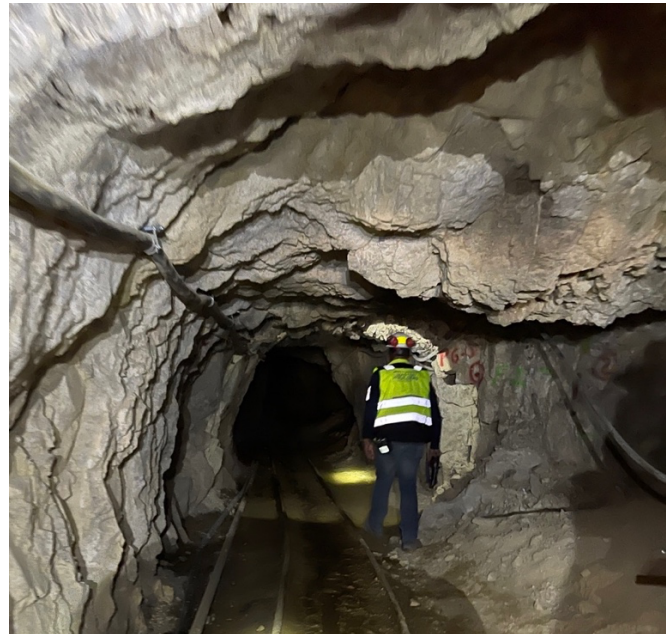
The El Carmen adit (Level 4) at El Pinguico
